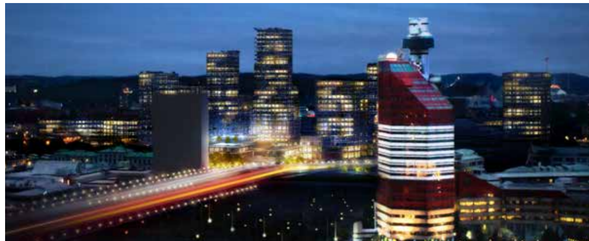
Området runt Göteborgs central är hela regionens hjärta. Här finns potential att förtäta med kontor, handel och bostäder. Visionsbild från Jernhusens planering för framtida bebyggelse vid centralstationen.
